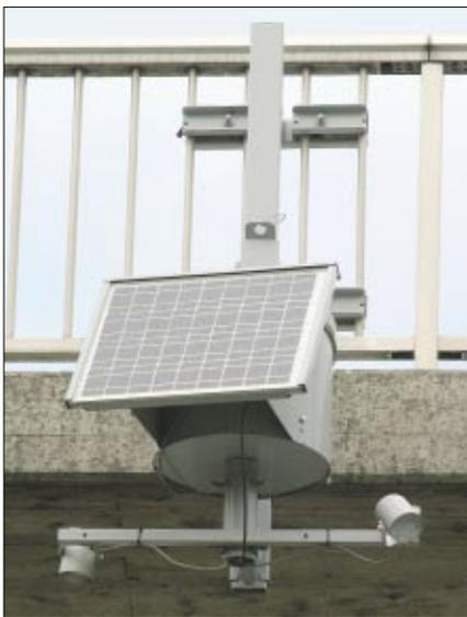
Diese Verkehrssensoren gehören der T-Systems, sie überwachen nur die jeweils ganz linken Spuren. Sie verfeinern das Netz der Induktionsschleifensensoren nur etwas.
