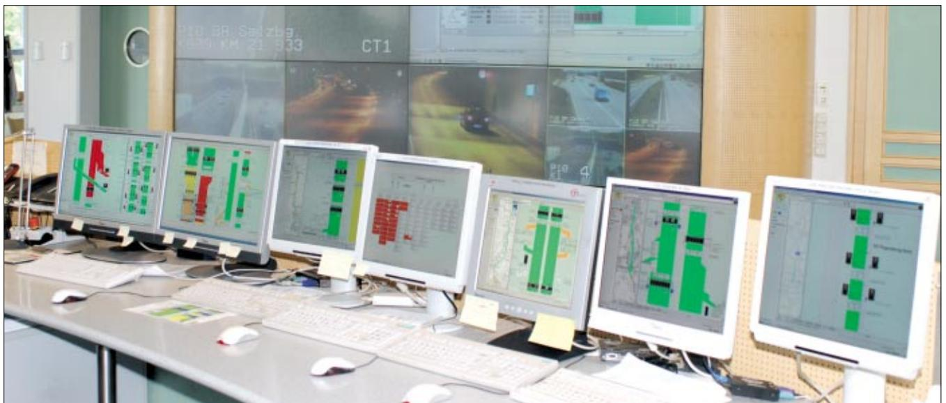
**Hier in der Verkehrsleitzentrale der Autobahndirektion Südbayern laufen die Infos der Fahrspuren zusammen. Auf dem linken Monitor sehen Sie rot eine Störung, die Sie im ersten Foto dieses Artikels wiederfinden.**
